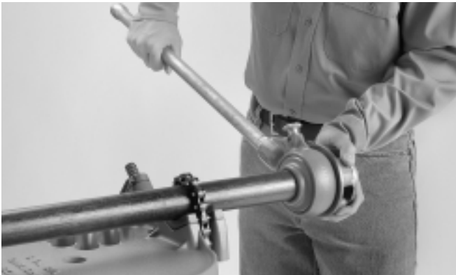
Figura 3 – Montaje de la Roscadora en el tubo
