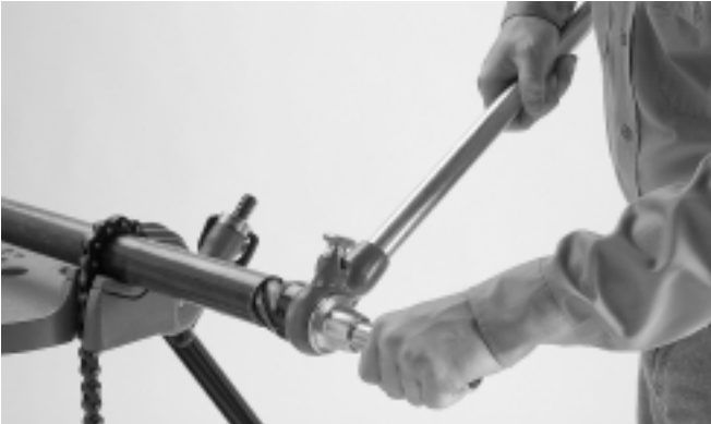
Figura 2 – Escariado del extremo del tubo
